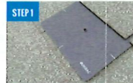
INSTALL FLASHKIT PRO FLASHING
